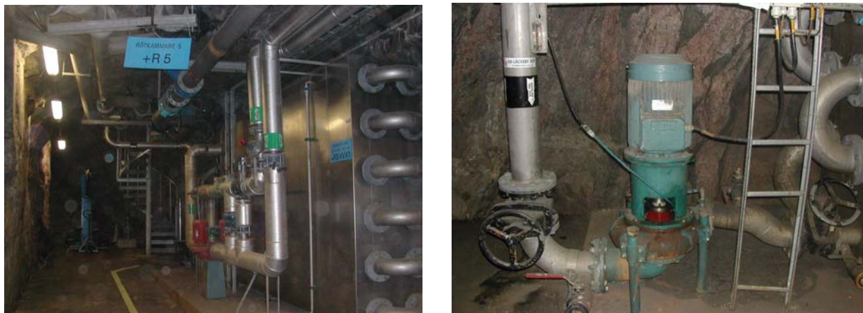
Figur 7 Till vänster - värmeväxlingslinan under röt-kammare 5 på Henriksdal. Till höger - doseringspunkten (längst ned till höger) för LiCl-lösningen.
